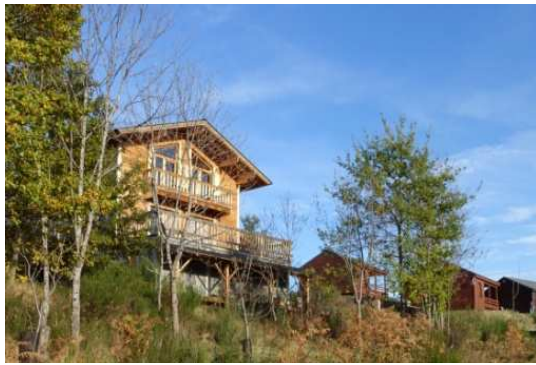
Orientation déstructurée des faitages de l'habitat récent
