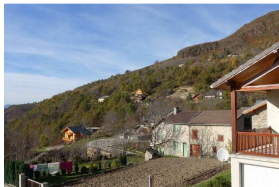
L'habitat périphérique, tissu urbain lâche, pavillonnaire à partir des années 80
